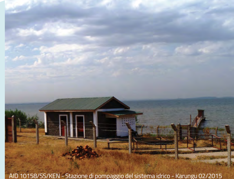
AID 10158/SS/KEN - Stazione di pompaggio del sistema idrico - Karungu 02/2015
